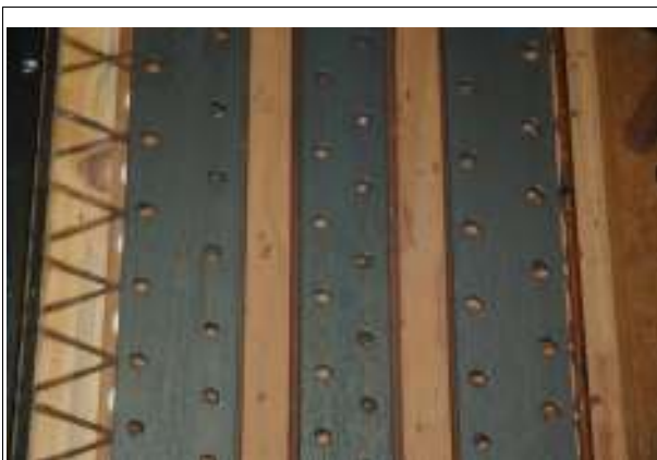
Abbildung 12: Blick auf die Schleifen des Schwellwerkes.
