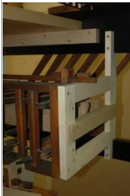
Abbildung 6: Neu angefertigter Tragrahmen für die Registerbetätigung des II. Manuals.
